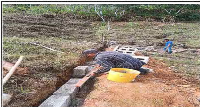
Foto 1: SUSTITUCION DE MURO Y MAYA PERIMETRAL
