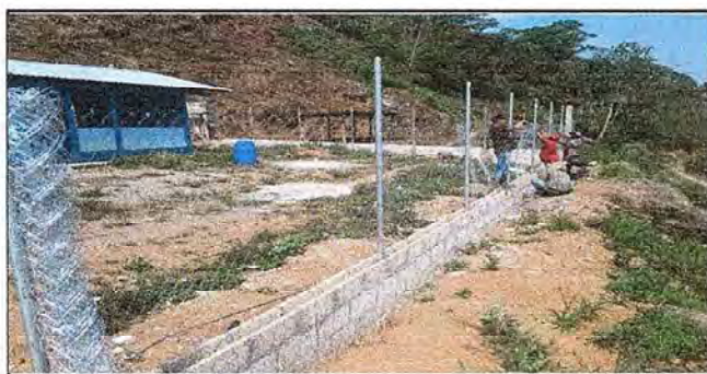
Foto 5: SUSTITUCION DE MURO Y MAYA PERIMETRAL
