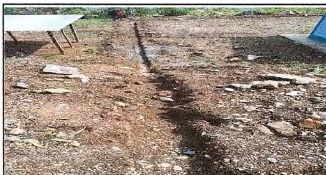
Foto 3: SUSTITUCION DE MURO Y MAYA PERIMETRAL
