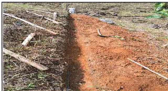
Foto 4: SUSTITUCION DE MURO Y MAYA PERIMETRAL
